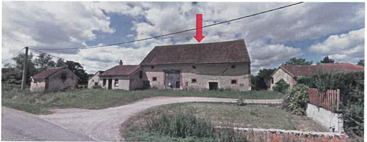
Bâtiment concerné par l'identification
