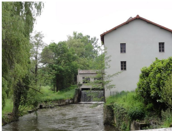
Moulin sur le bief de la Sioule.
