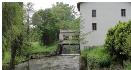
Moulin sur le bief de la Sioule.
